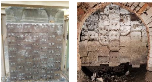
دمپر بتنی چپ (پس از ساخت) راست: پس از شش ماه سرویس دهی
